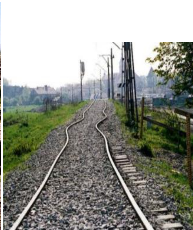
Rys. 3 i 4 Szkody na powierzchni w niecce osiadań w rejonie Klasztoru o.o. Franciszkanów-Reformatów i linii kolejowej
