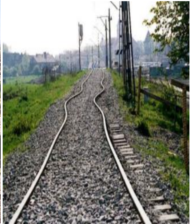
Rys. 6 i 7 Szkody na powierzchni w niecce osiadań w rejonie Klasztoru o.o. Franciszkanów-Reformatów i linii kolejowej
